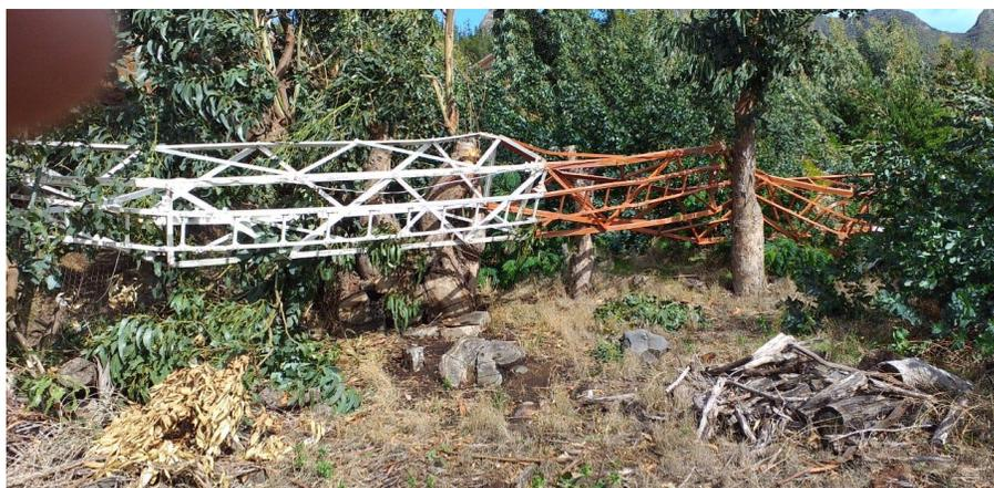
Foto 4 – Antena colapsada
