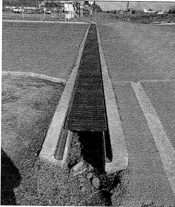
Fig.3 Canaleta evacuación aguas lluvias
