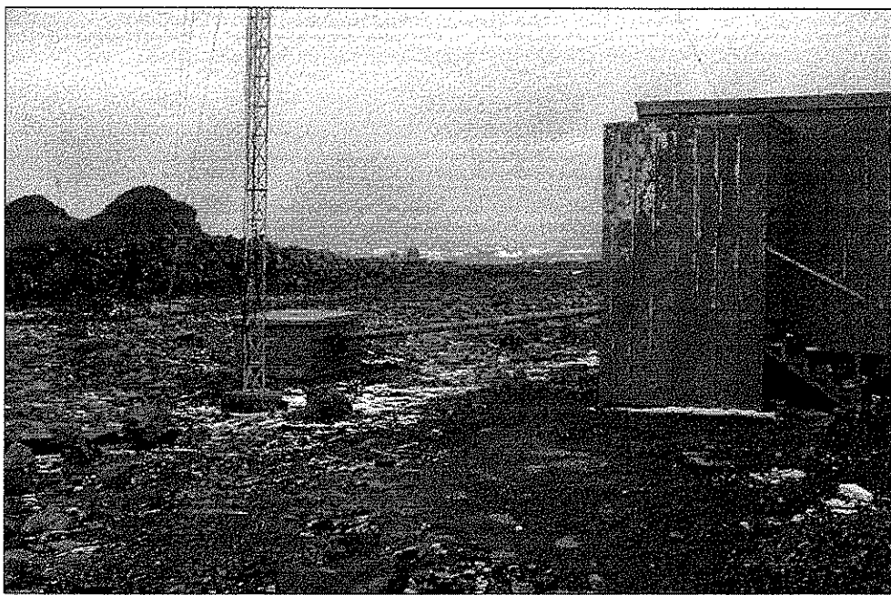
Imagen N°5. Junto al módulo de la planta de tratamiento de aguas servidas utilizada anteriormente se encuentra un depósito donde se recibirá el efluente ya tratado.
