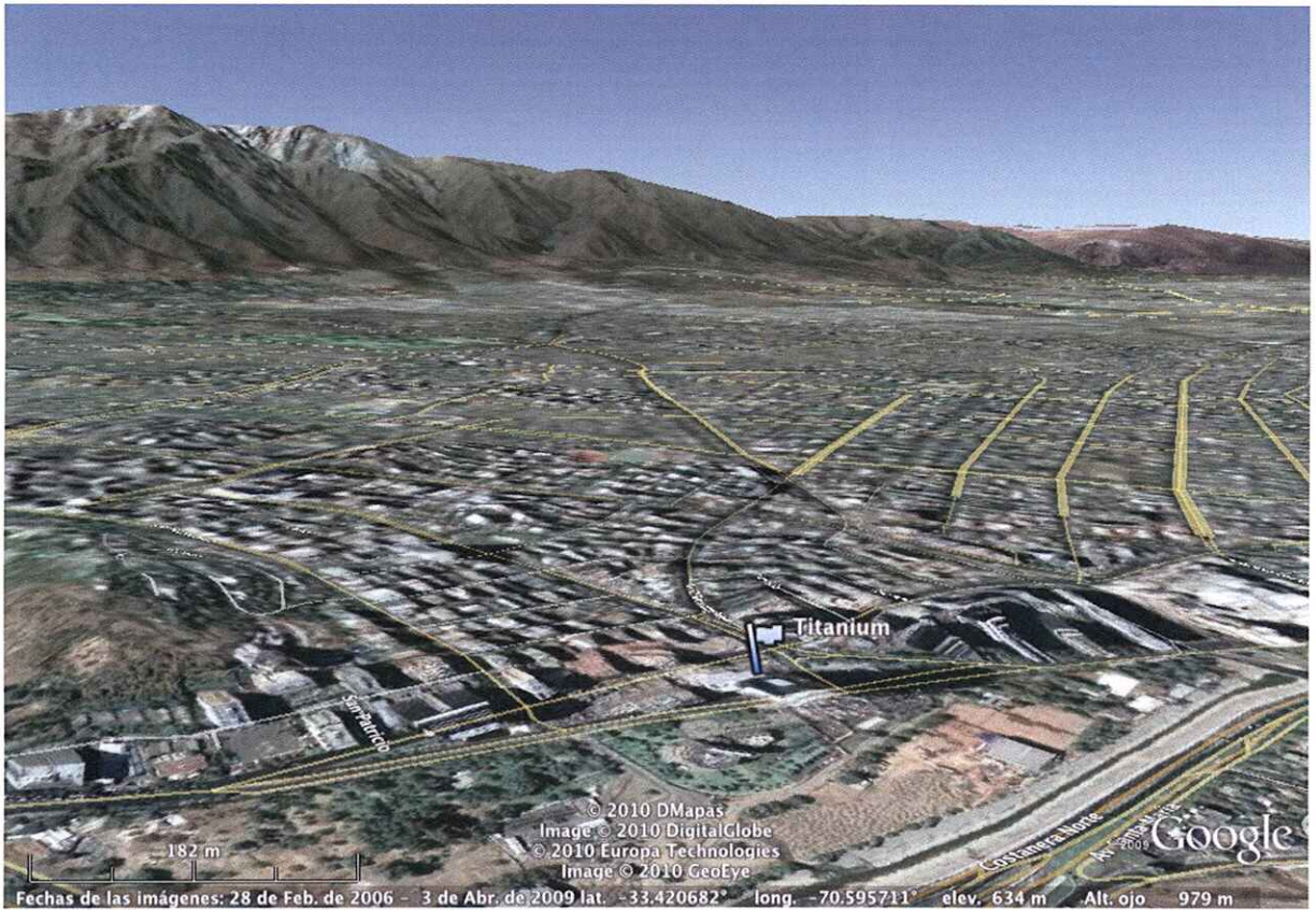
Figura 3 Vista hacia el S, SE desde Edificio Titanium
