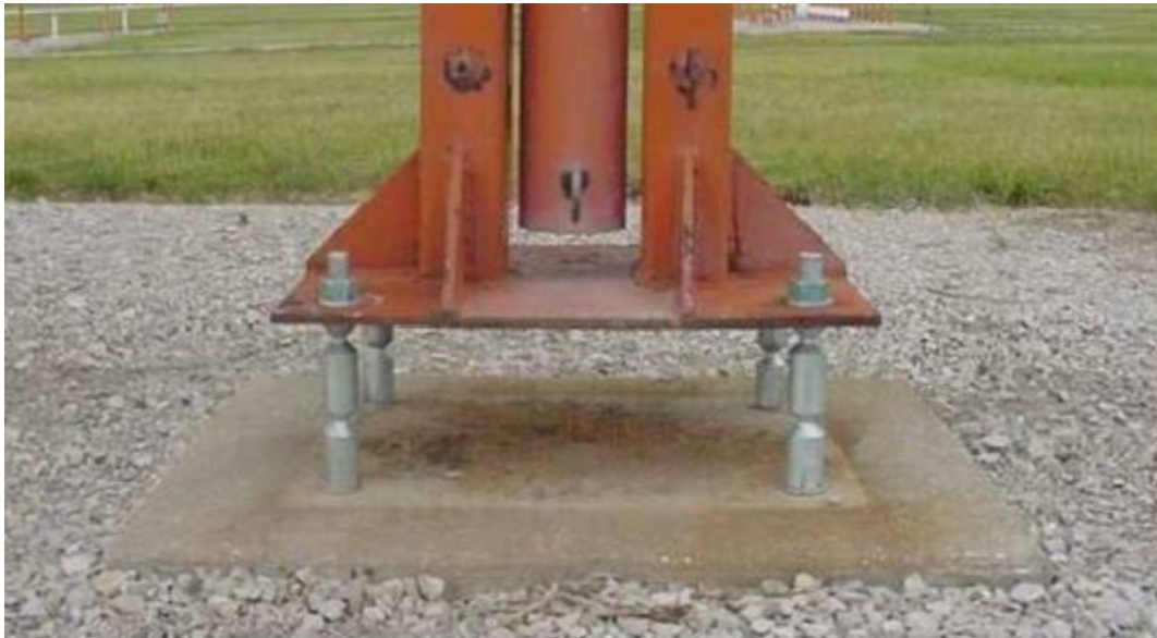
Figura ADJB-3. Aplicación de un perno fusible
