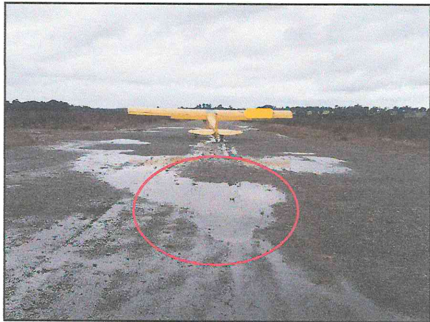
Fotografía 1: Acumulación de agua lluvia en el eje de la pista 34.
