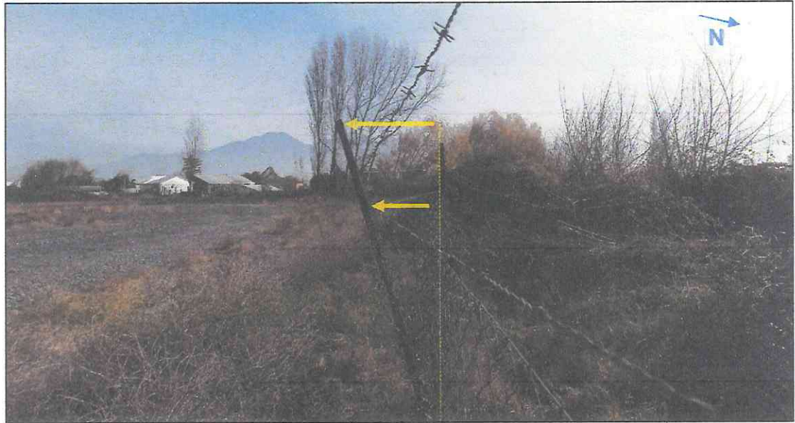
Imagen N°01, poste del cerco impactado.
