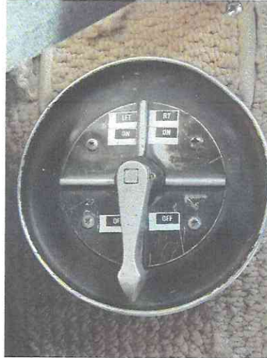
Fotografía n° 1. Vista de la selectora de combustible.
