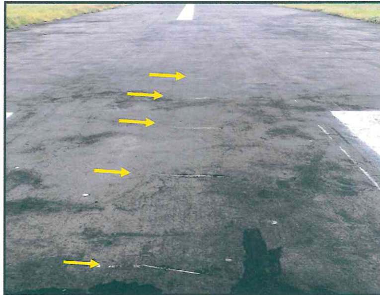
Fotografía 2: Impactos de las palas de la hélice.
