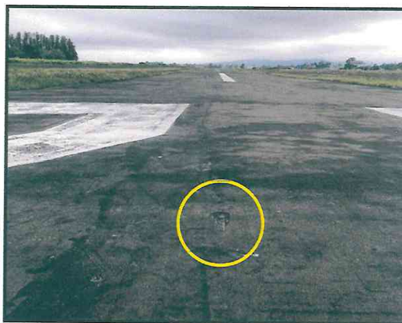
Fotografía 1: Surco en la pista con evidencia de color azul.
