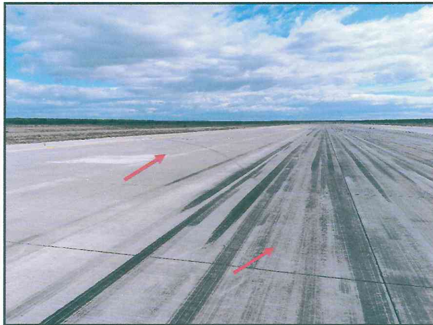
Fotografía 1: Huella de la rueda izquierda del tren de aterrizaje.
