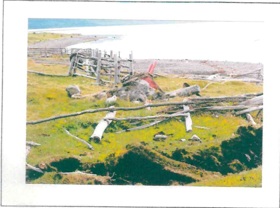
PUNTO DE IMPACTO MOTOR N° 1 EN BASE DE CEMENTO CON TUBOS Y RIEL
