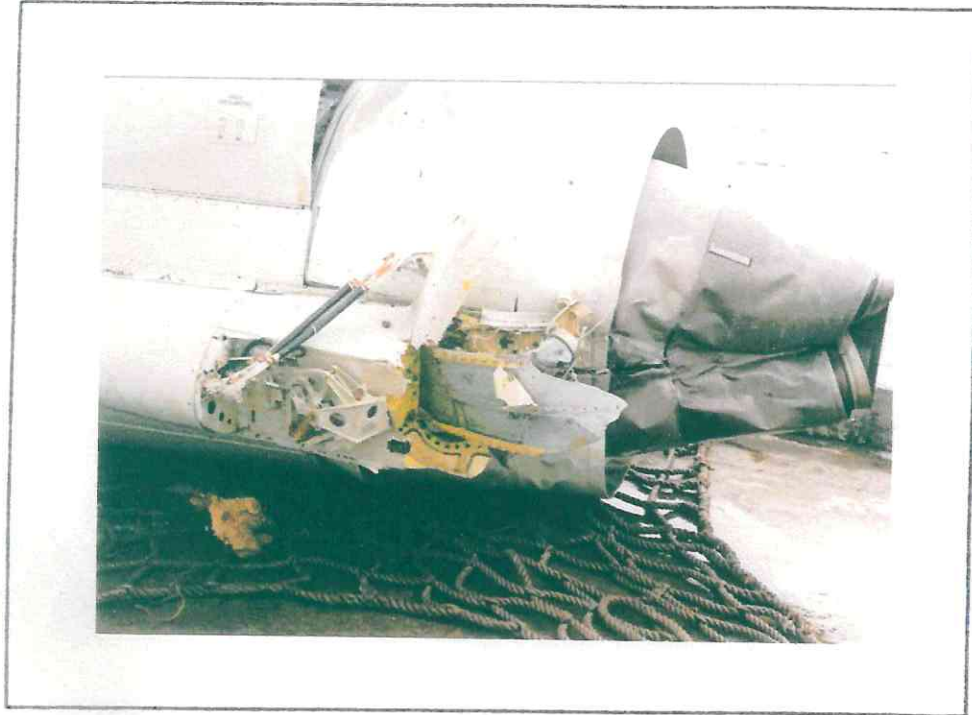
Area de puntos de amarra al pylón, donde se desprendió el motor N° 1.
