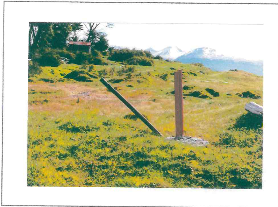
BASE DE CEMENTO SIMILAR A LA FOTOGRAFIA ANTERIOR
