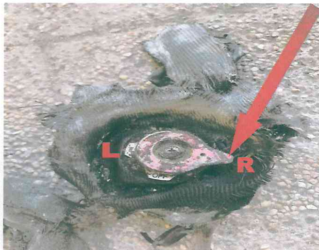
Fotografía N°4: Válvula de combustible en posición derecha (R).
