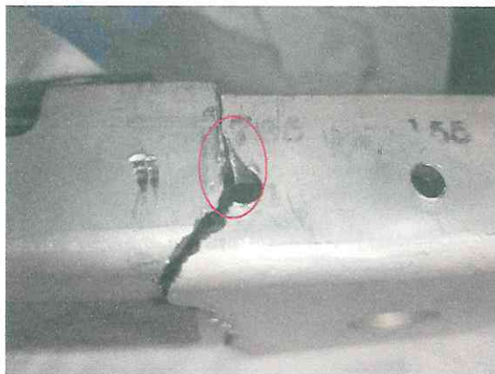
Fotografía N°3: Vista posterior inferior de la zona de inicio de una de las fracturas.
