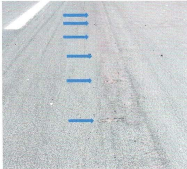
Fotografía N° 2: Vista de las huellas del contacto de las palas de la hélice.
