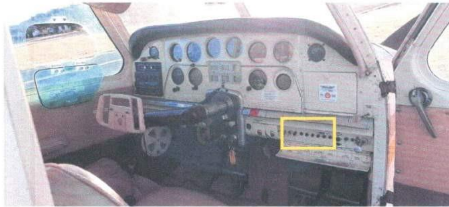
Fotografía N° 7: Vista de la cabina y su panel con circuit breakers (cuadro amarillo).
