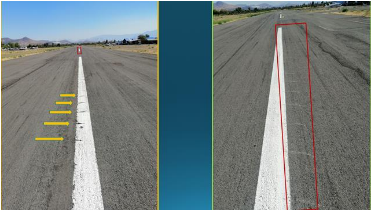
Fotografías N° 10 y 11: Vista de las 5 marcas iniciales y de las marcas finales en la pista.
