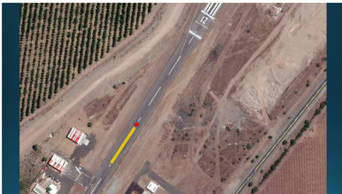
Imagen N°2: Vista de la zona de impacto de la hélice con la pista (demarcación roja).
