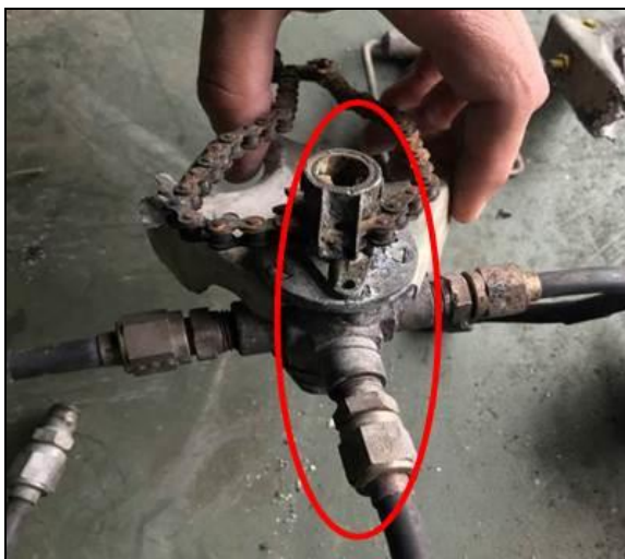
Fotografía 12. Válvula Principal de combustible del lado izquierdo (Main Fuel Cock).
