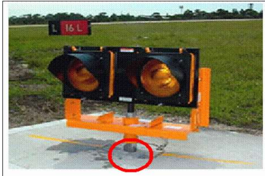
Figura ADJB-5. Ejemplos de Cuplas Frangibles
