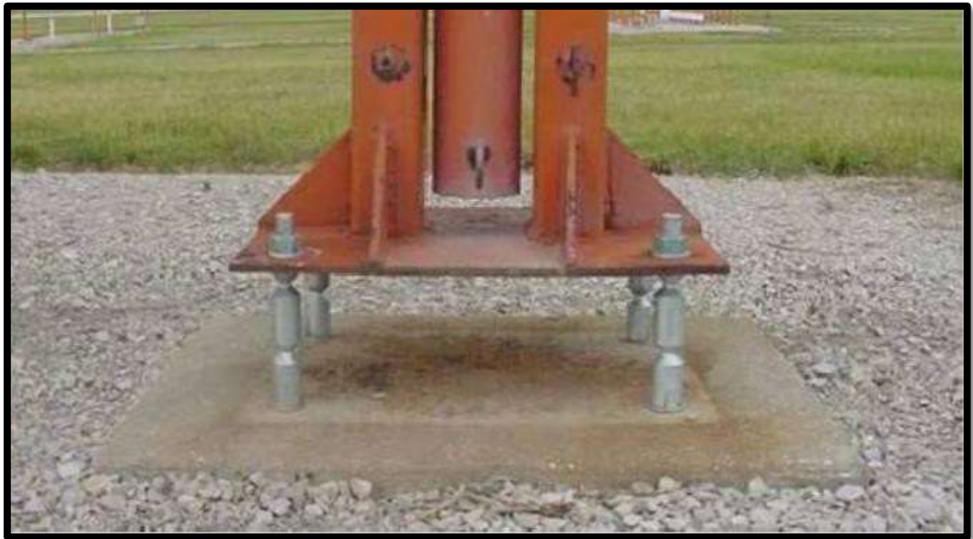
Figura ADJB-3. Aplicación de un perno fusible
