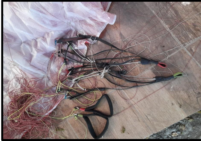
Fotografía N°3: Suspenes y sistemas de control.
