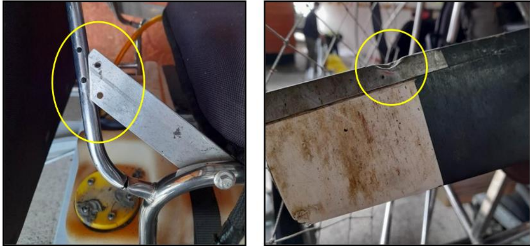
Imágenes N°3 y 4; Soporte de la estructura y pala de la hélice
