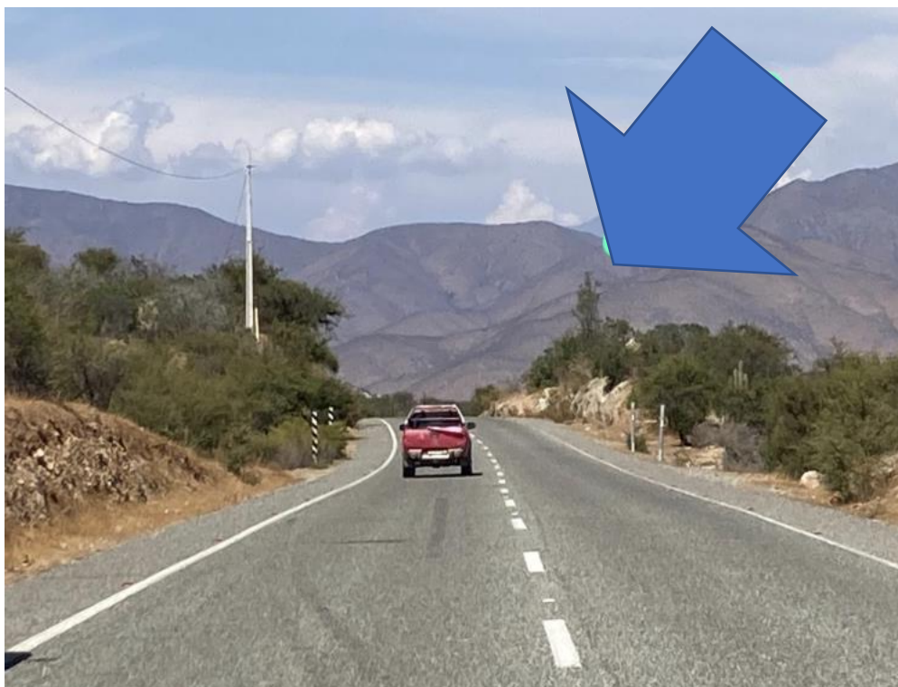
Fotografía 1: Vista general de la carretera, donde aterrizó la aeronave.
