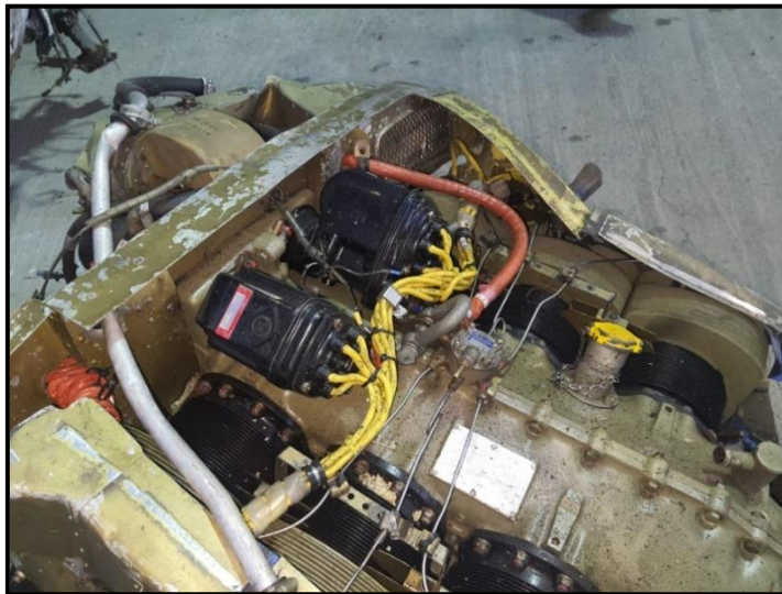
Fotografía N°07: Vista general del motor
