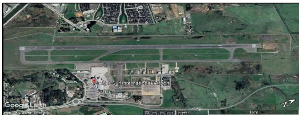
Imagen N°21: Vista de SCIE, antes de iniciar trabajos de normalización.
