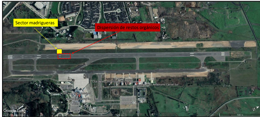
Imagen N°9: Ubicación de las madrigueras costado oeste de la pista.
