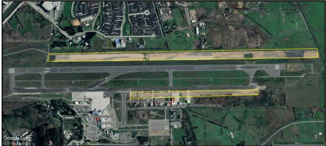
Imagen N°22: Vista de SCIE con trabajos de normalización, previo al suceso.
