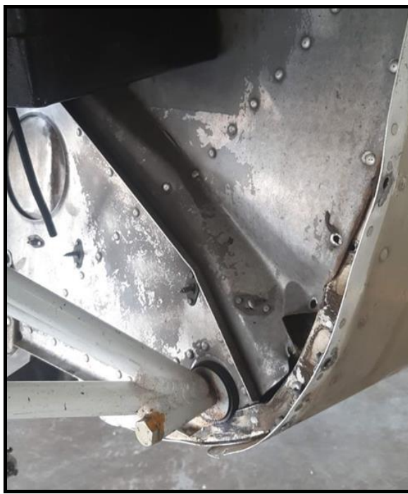
Fotografía 5: vista del mamparo cortafuego.
