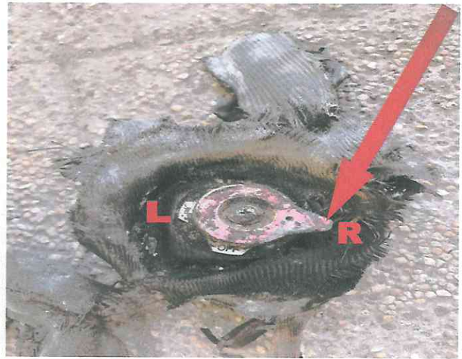
Fotografía N°4: Válvula de combustible en posición derecha (R).
