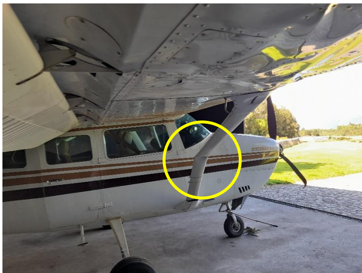
Fotografía N° 8: Vista del montante doblado.
