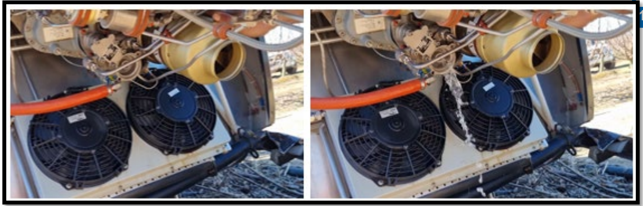
Fotografías N°12 y N°13: Prueba de la válvula Shut Off.
