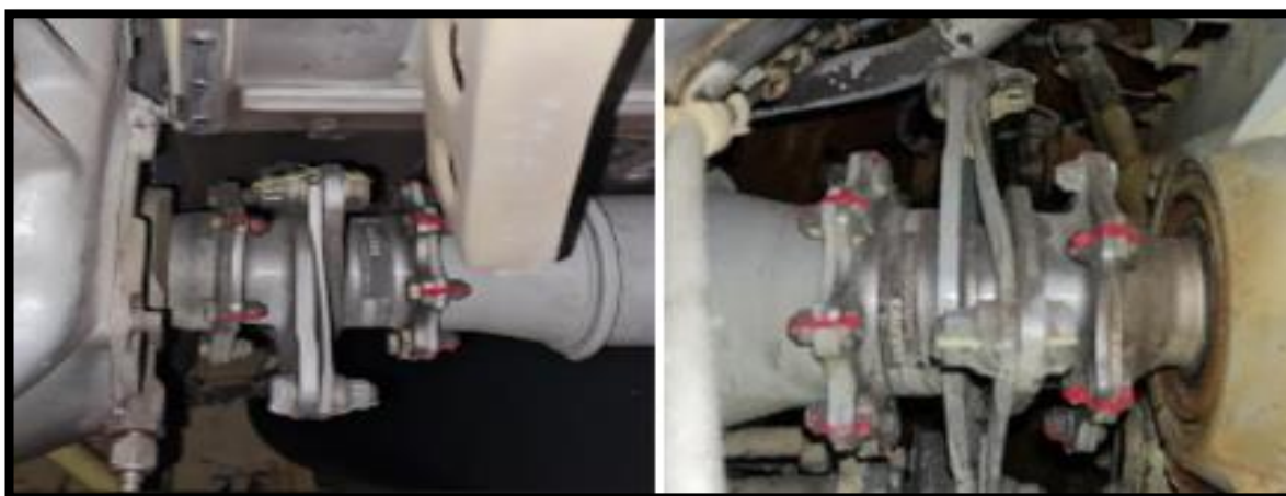
Fotografía N°11: Eje de transmisión principal.
