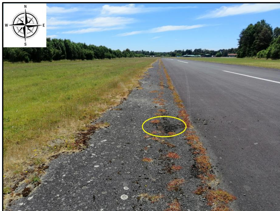
Fotografía N° 3: Vista de la huella de impacto de la hélice contra el asfalto (círculo amarillo).
