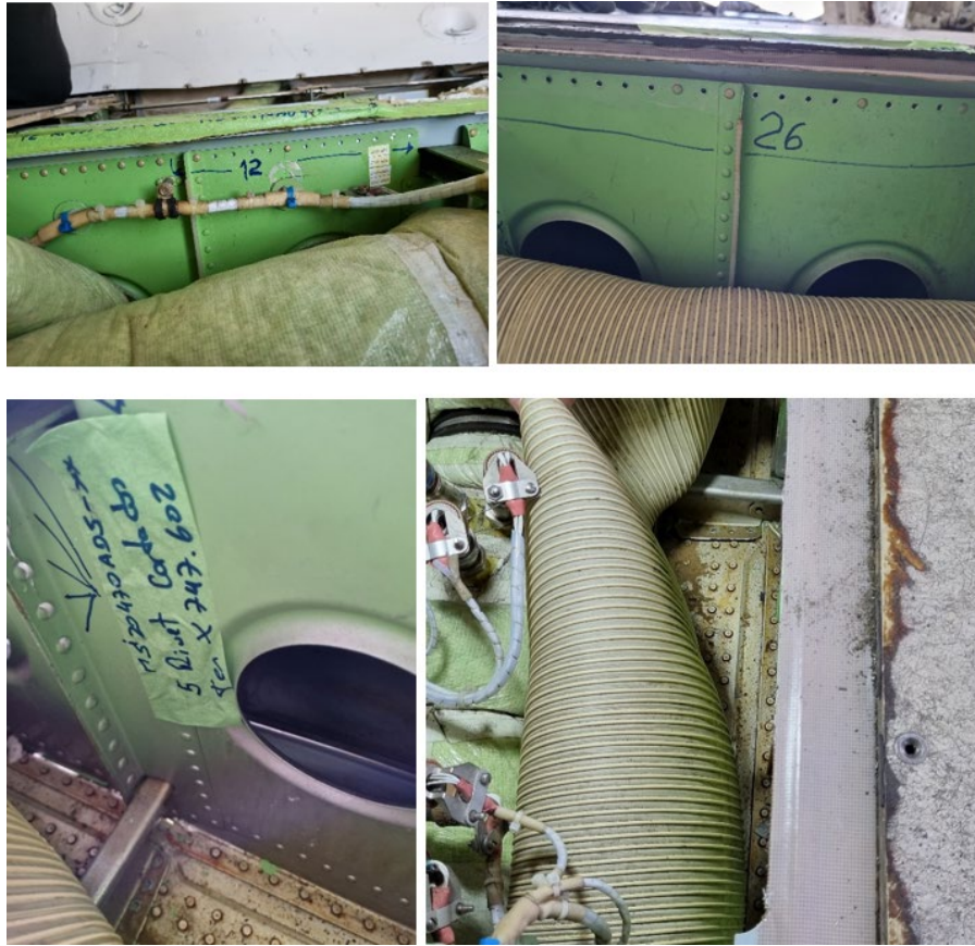
Fotografías N° 10, 11, 12 y 13: Vista de la estructura interior bajo el piso del compartimento de carga.
