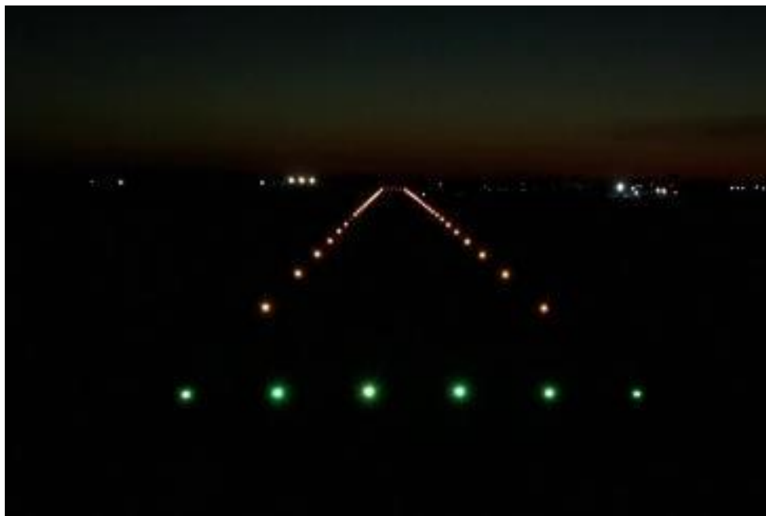
Fotografía N°4: Luces de borde de pista y de identificación de umbral de pista.
