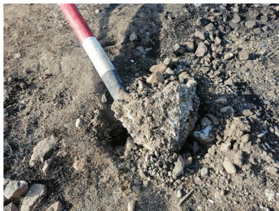
Fotografía N°6: Vista de la base de concreto de uno de los polines con que impactó la aeronave.
