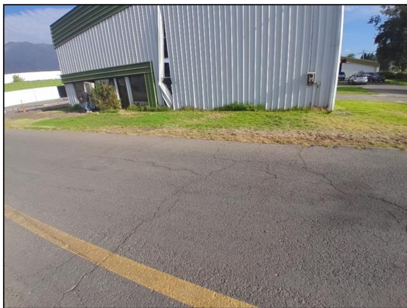
Fotografía N° 2: Hangar con daños provocados por la aeronave.
