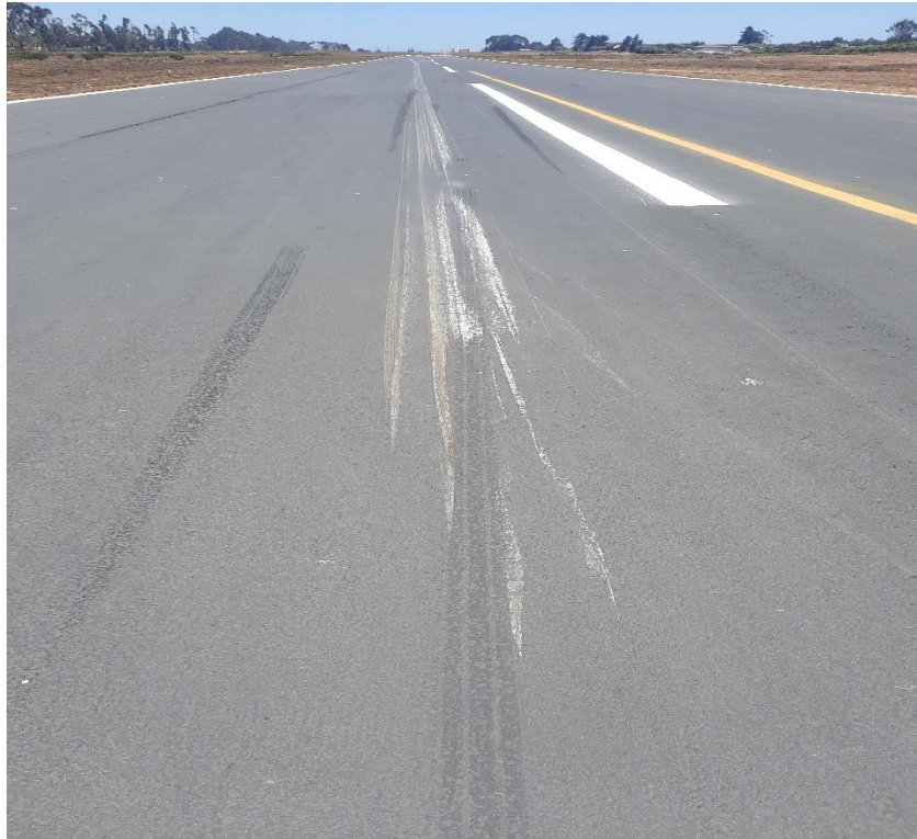
Fotografía N° 12: Vista de la zona de impacto de los portalones del tren de nariz en la pista.
