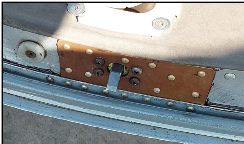
Fotografía N° 4: Reparación estructural y sellado en marco trasero de puerta de acceso a la cabina efectuado el día 02 de septiembre de 2022.
