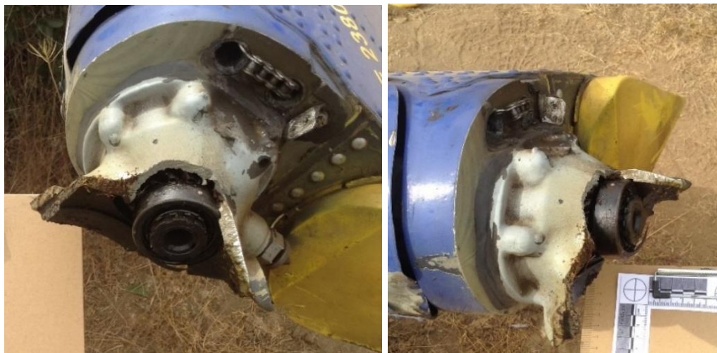
Fotografías N° 13 y 14: Zona de fractura en la caja de engranajes de 90°.
