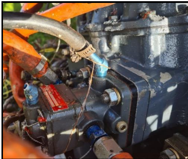
Fotografía N°45: Bomba de combustible.
