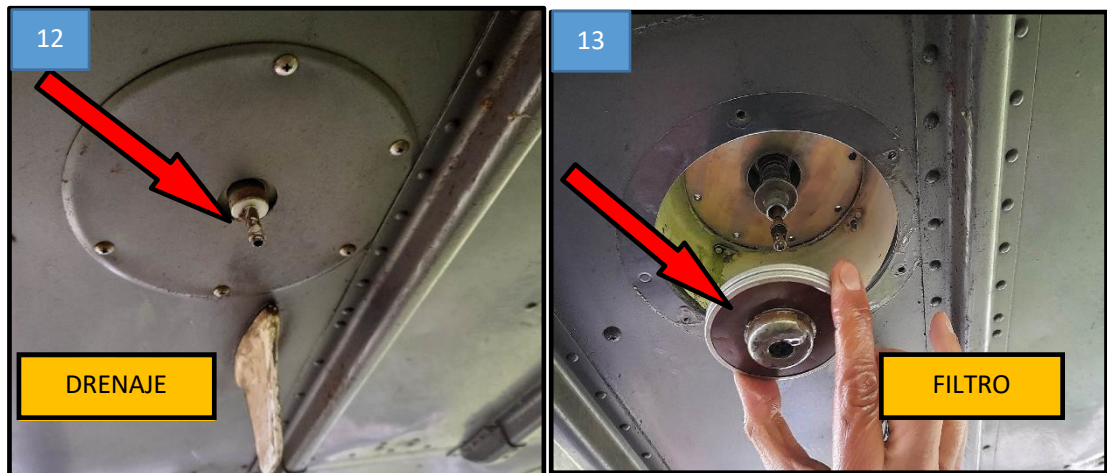
Fotografías N°12 y 13: Vista del drenaje y filtro de la válvula de combustible.
