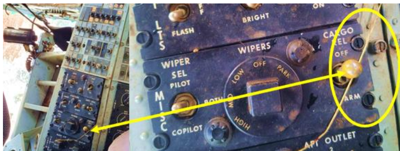
Fotografía N°29: Interruptor "CARGO REL" en posición OFF.
