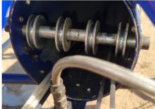
Fotografía N°17: Poleas guías de los cables de control del timón de dirección y del elevador.
