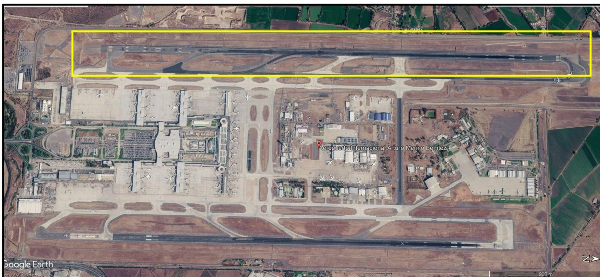
Imagen N°1: Pista 17R, Aeropuerto Arturo Merino Benítez (SCEL).
