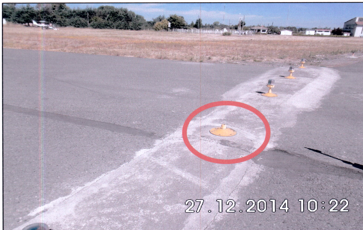
Fotografía 3: Luz de pista quebrada, producto del desplazamiento de la aeronave, al salir de la pista.
