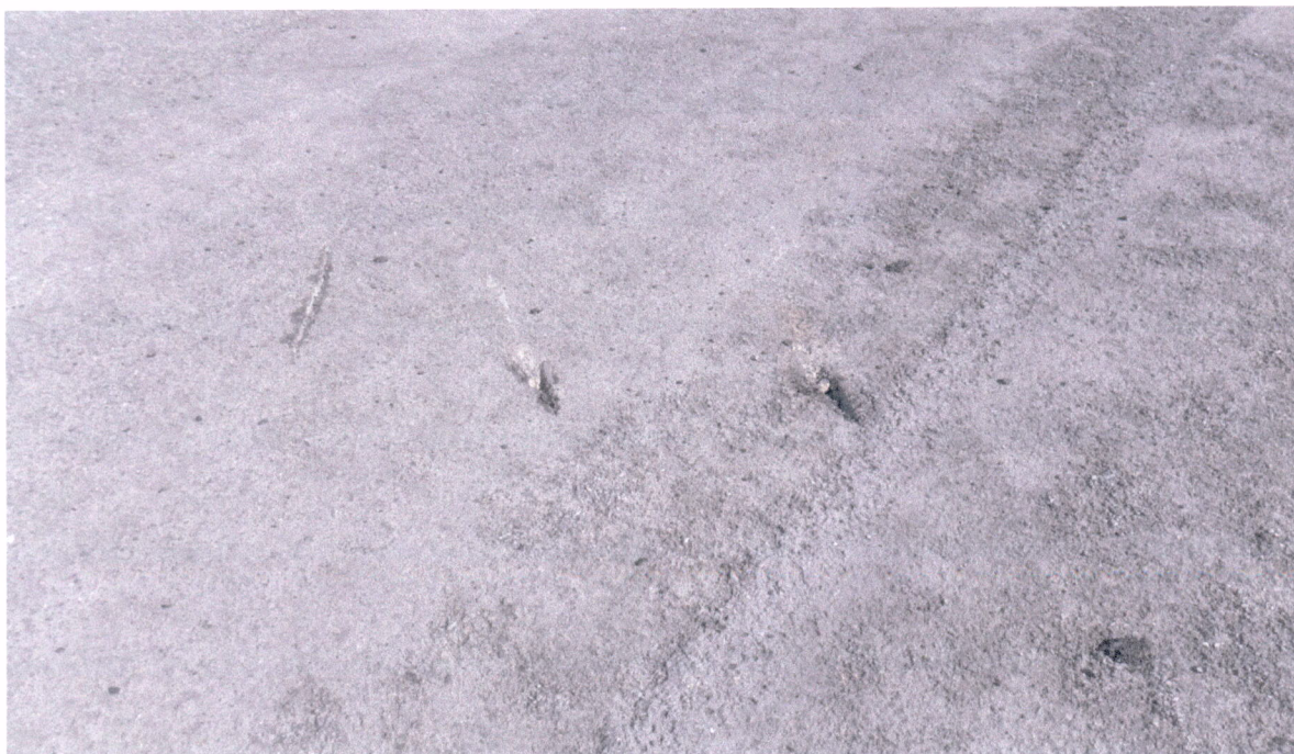
Foto N° 2 marcas de golpes de la hélice en la superficie de la pista.
